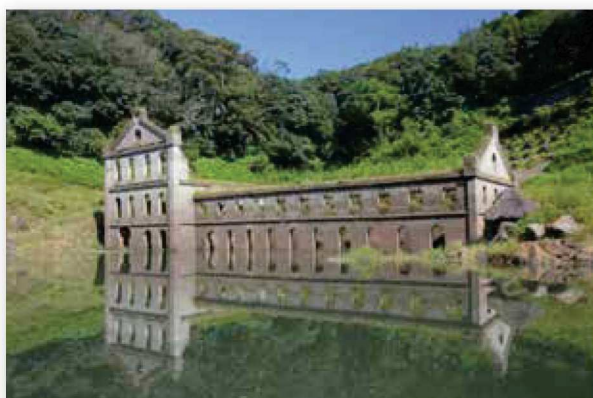
曾木発電所遺構(国指定有形文化財)
